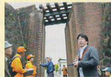
明治のレンガ積橋台
